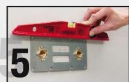
Percer les huit trous de fixation dans la cloison en veillant à ne pas percer les tubes.
