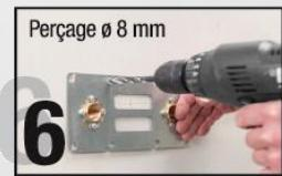
Fixer la platine à l'aide des vis et chevilles fournies. Retirer les vis lorsque les chevilles sont expansées, pour une meilleure planéité.
