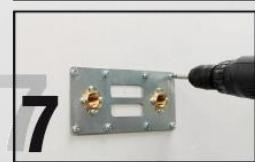
Serrer de façon définitive les vis de fixation des coudes sur la platine.
