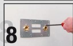
La platine, par son épaisseur réduite, sera facilement noyée dans le ciment colle utilisé pour la pose de la faïence.
