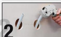
Positionner les coudes sur les tubes et réaliser le sertissage.
