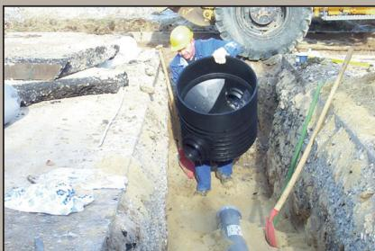
B - Le raccordement aux tubes s'effectue par simple emboîtement après graissage de l'emboîture et du tube.
