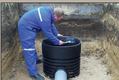
C - Assembler l'élément de réhausse en exerçant une pression verticale.
