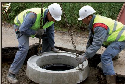
Pour mettre l'ouvrage à la cote, il est possible de réhausser ou surbaïsser la couronne de 10 cm maximum. Cette opération nécessite un désassemblage de la couronne pour ajuster le niveau de remblai.
