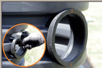
La butée extérieure du joint doit venir se plaquer sur la paroi extérieure de la réhausse.
