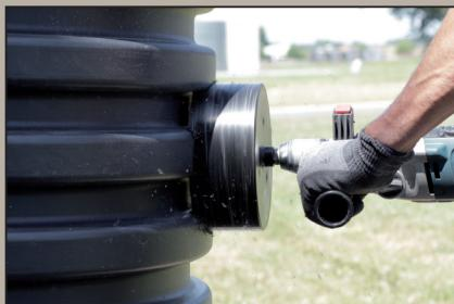
Le perçage doit être fait bien perpendiculairement à la réhausse. La fraise doit être en bon état pour réaliser correctement le perçage.
