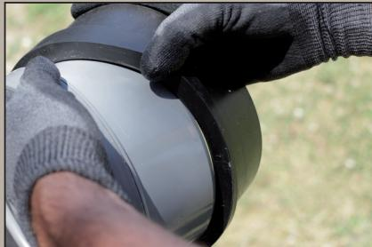
D - Monter le joint à sec sur la réhausse en orientant verticalement les flèches gravées (Tegra 600 uniquement).
